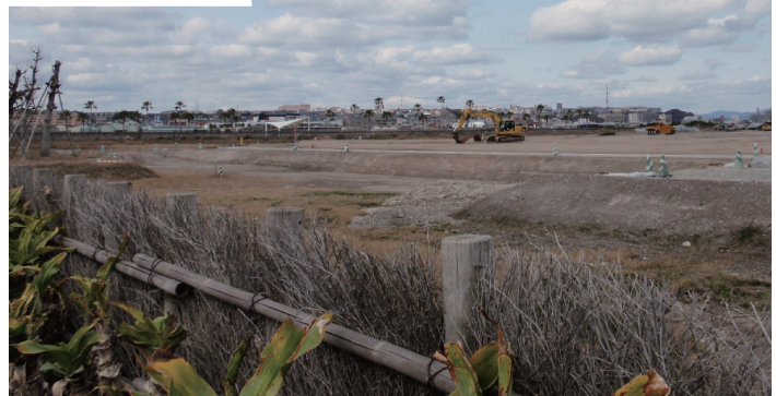
建設中のマリンポートかごしま
