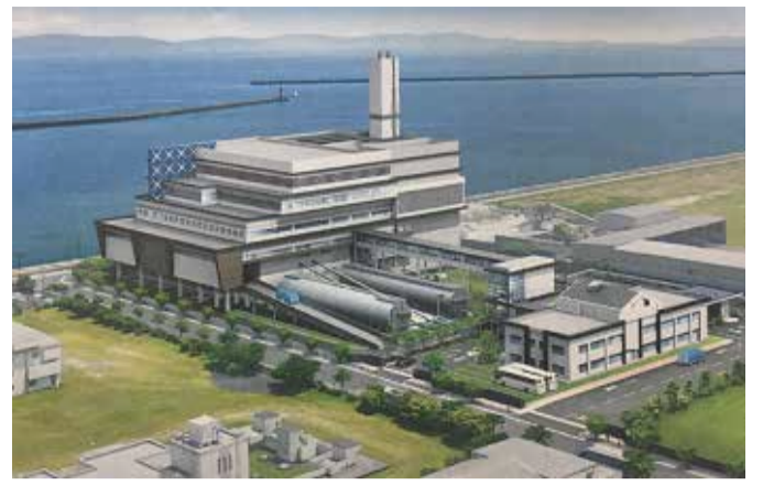
完成予想図。DBO方式により川崎重工業グループに発注し、設計・建設は約4年間を要し平成34年1月から20年3か月間運営する。総額324億円。バイオガス施設のガスは日本ガスに売却する。売電・売ガスの収入見込みは74億8千万円。
